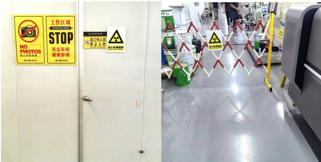
图 3-2 低能电子束辐照装置监督区围栏、警示标识
